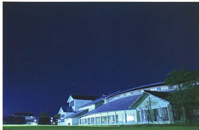
(撮影：フレンドリープラザ職員 米野哲郎)
